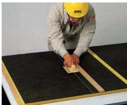
2. ダクト内寸法の4辺合計値に210mmを加算した長さにダクトボードを切断し40mmのフラップを作ったあと、この部分を銀色工具でメス型にカットします。
