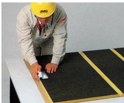
3. フラップと直角方向のダクトの一端を銀色工具でメス型にカットします。
