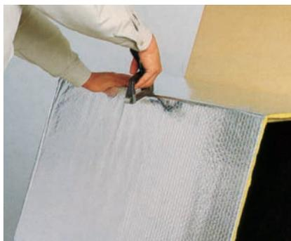
6. 専用テープで接合部をヘラを使って完全に摩擦圧着させます。
