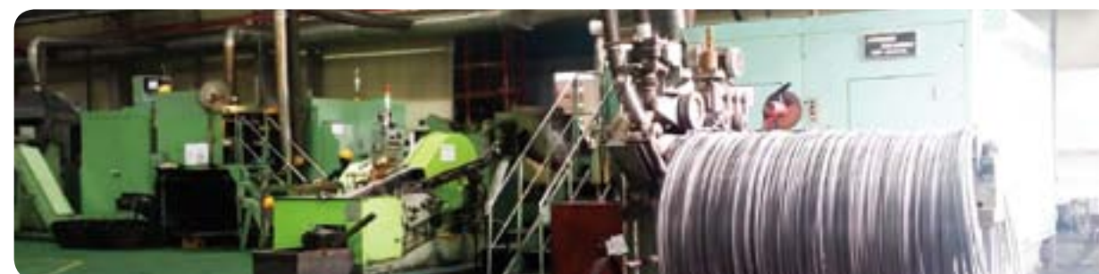
03 열처리 장비 Heat Treatment Facility
